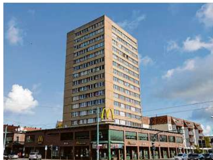
Hochhaus Karl-Marx-Straße 23 (rechts Fertigstellung in 2023)
